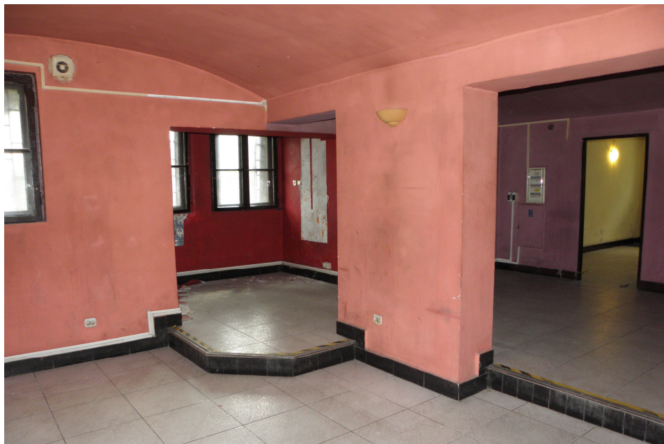
Widok wewnętrznych ścian nośnych, pomieszczenie z obniżoną posadzką o 18 cm.
