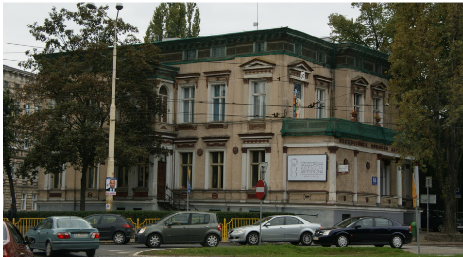
Elewacja południowo – wschodnia i północno – wschodnia. Widok od strony pl. Szarych Szeregów
